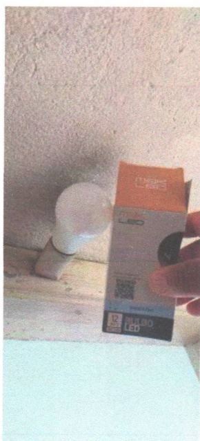
Troca luz banheiro da farmácia
