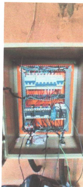
Troca relé de falta de fase bomba auxiliar sistema de bombeamento de água
