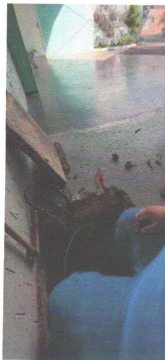
Limpeza caixa de passagem rede elétrica
