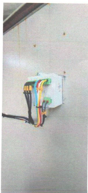
Troca de multimetro De Grandezas Eletricas
