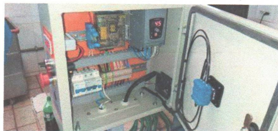
Parametrizar inversor centrífuga lavanderia
