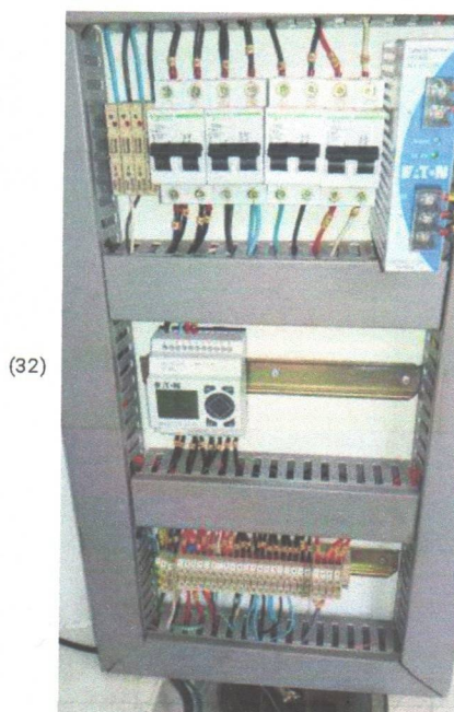
Ajuste fonte 24v painel casa de maquina
