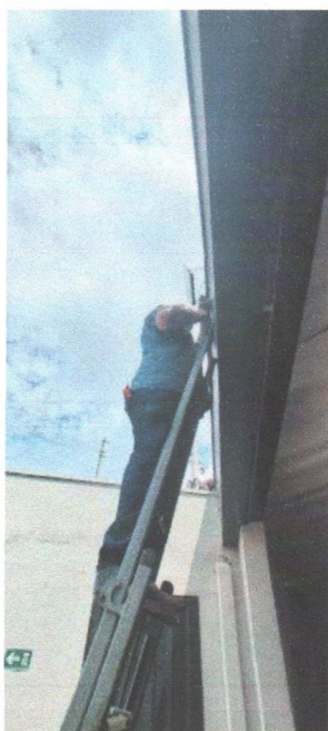
Troca refletor fachada entrada de ambulância
