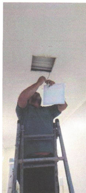
Troca de plafon corredor
