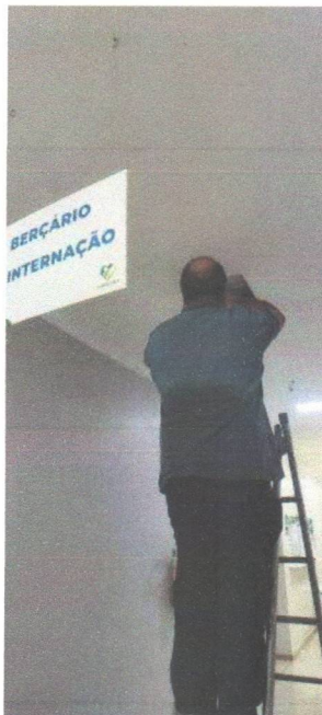
Troca plafon corredor
