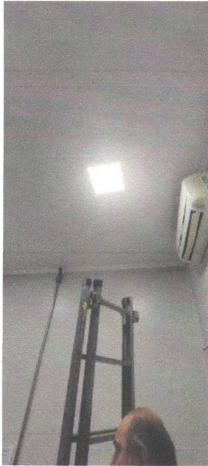
Troca plafon 24w sala de gesso
