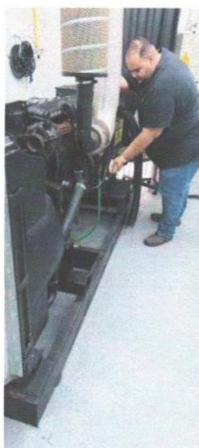
Reaperto cabos de aterramento devido a vibração
