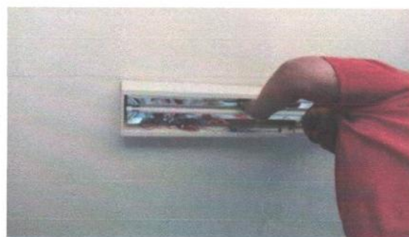
Troca luz tubular led depósito Cozinha
