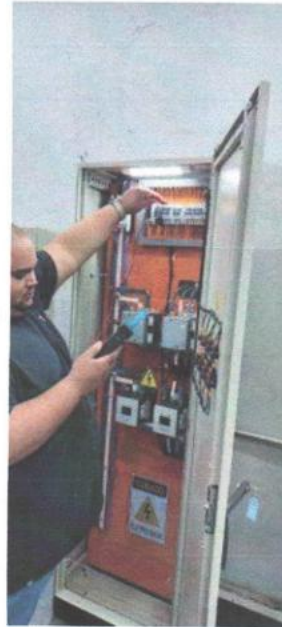
Test e reparos painel de transferencia de emergência
