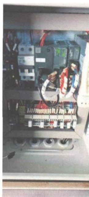
Revisão painel elétrico casa de máquina
