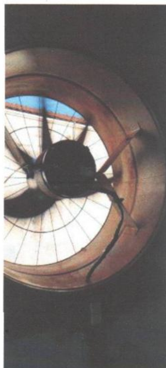
Troca exaustor 2 usina de oxigênio
