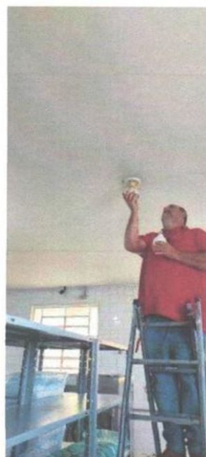
Troca de luz sala de esterilização
