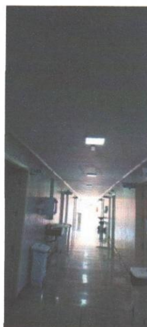
Troca de 9 plafon 24w corredor quartos
