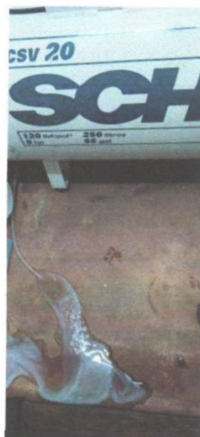
Drenando reservatorio ar comprimido
