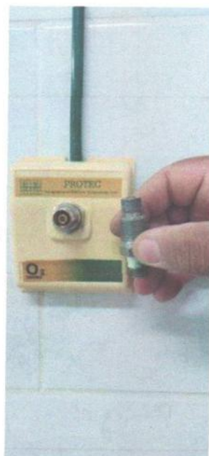
Troca de valvula de oxigênio posto de parede
