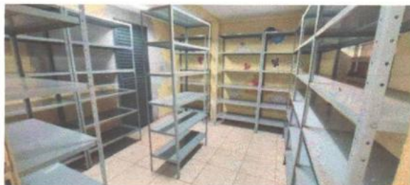
Montagem de armários para almoxarifado
