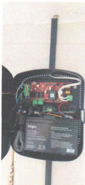
Troca de rele de interface Biometria corredor SME
