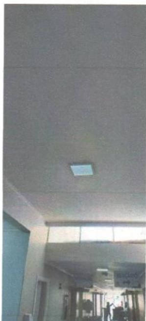
Troca plafon 24w posto de enfermagem bloco B
