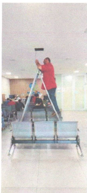
Troca plafom recepção
