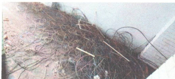
Cabos velhos dos forros retirados
