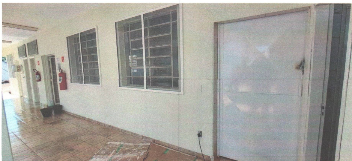
Vista externa após instalação e alinhamento do conjunto.
