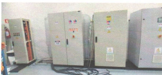
Posicionamento dos painéis novo
