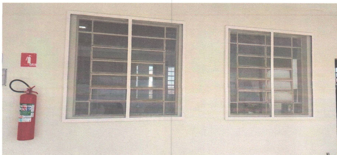
Resultado final com esquadrias e acabamento concluídos.
