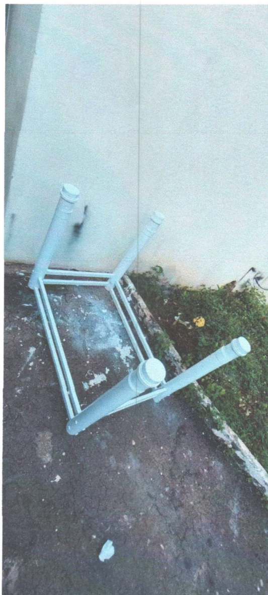
Estrutura recuperada, montada e preparada para acabamento.
