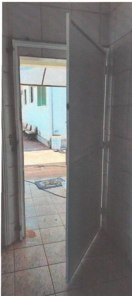
Instalação e ajuste final da porta metálica no local.
