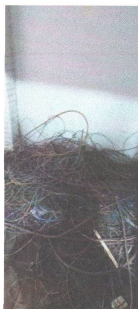
Cabos velhos retirados do espaço onde vai ser o centro de imagem
