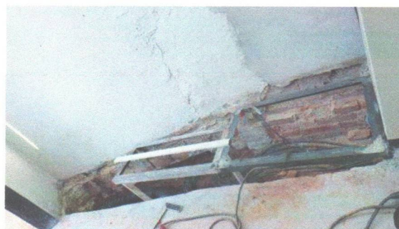
Ampliação da canaletas de passagem de cabos elétricos
