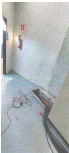
Retirada de cabos da canaleta para ampliação
