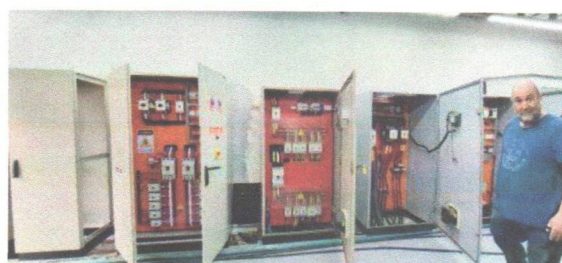
Manutenção dos painéis sala gerador
