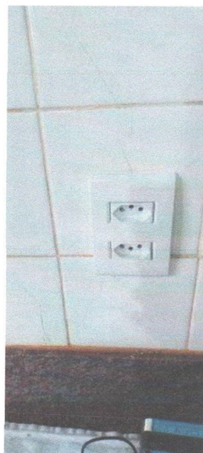
Troca de tomada sala de expurgo
