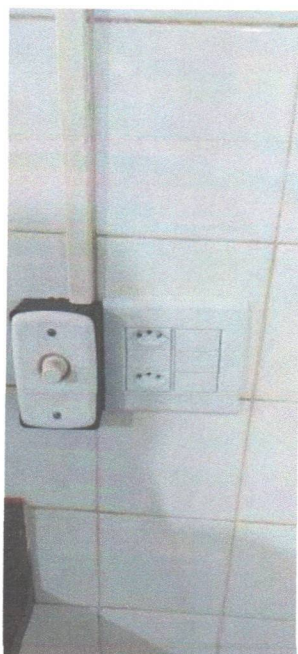
Troca de tomadas e interruptor sala de expurgo
