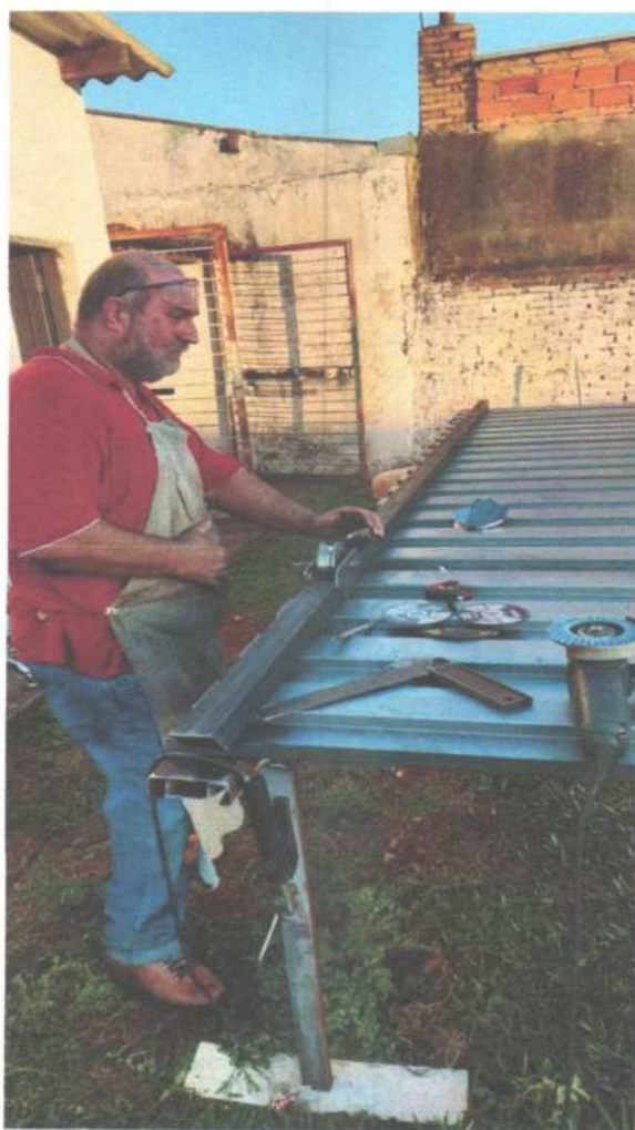
Acabamento da estrutura.
